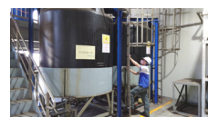
廢水處理系統
