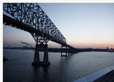
ボルチモア港の橋の一部崩落が、ロールオン・ロールオフ貨物の輸出入に影響を与えている。
